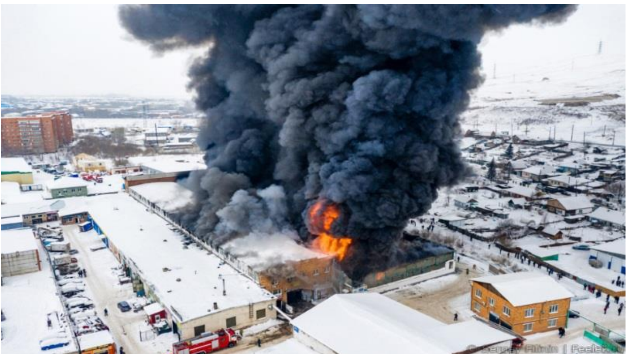
Рисунок 4 – Пожар в складском здании г. Красноярск
