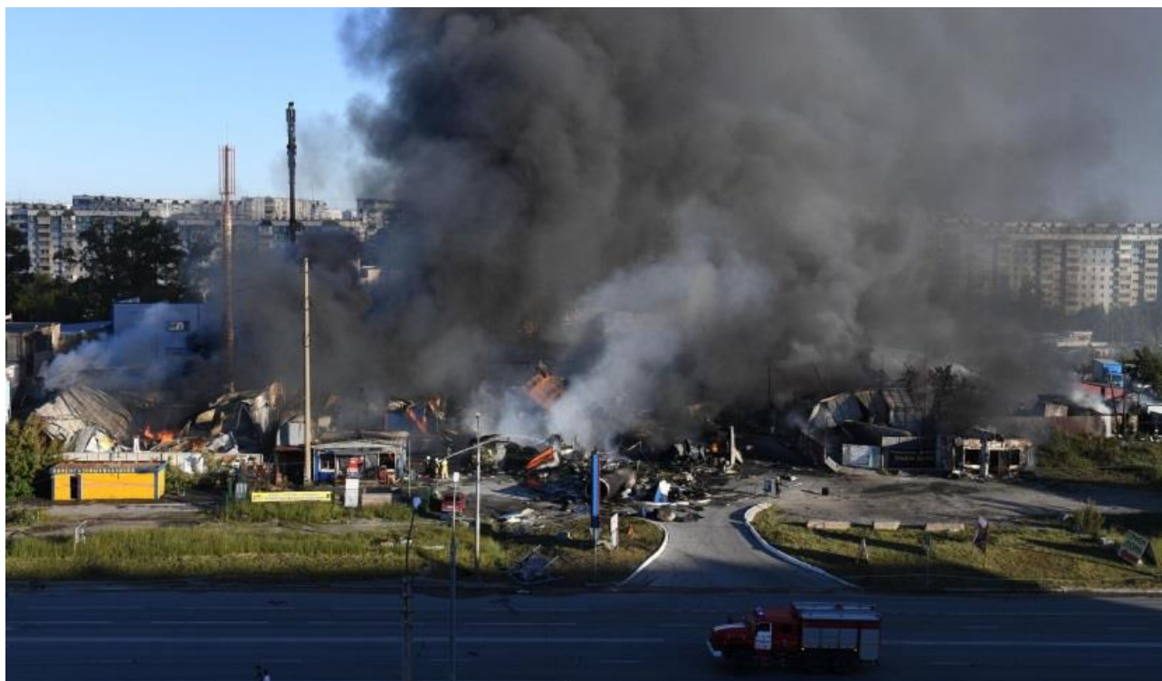
Рисунок 1 – Крупный пожар на Кузбасской обогатительной фабрики «Березовская»
